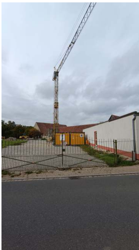
Bild: Ein einsamer Kran macht noch lange keine Baustelle! Blick auf das Areal neben dem Container.
